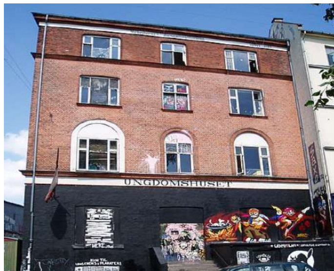
Figura 20. Edifici abans de ser enderrocat
