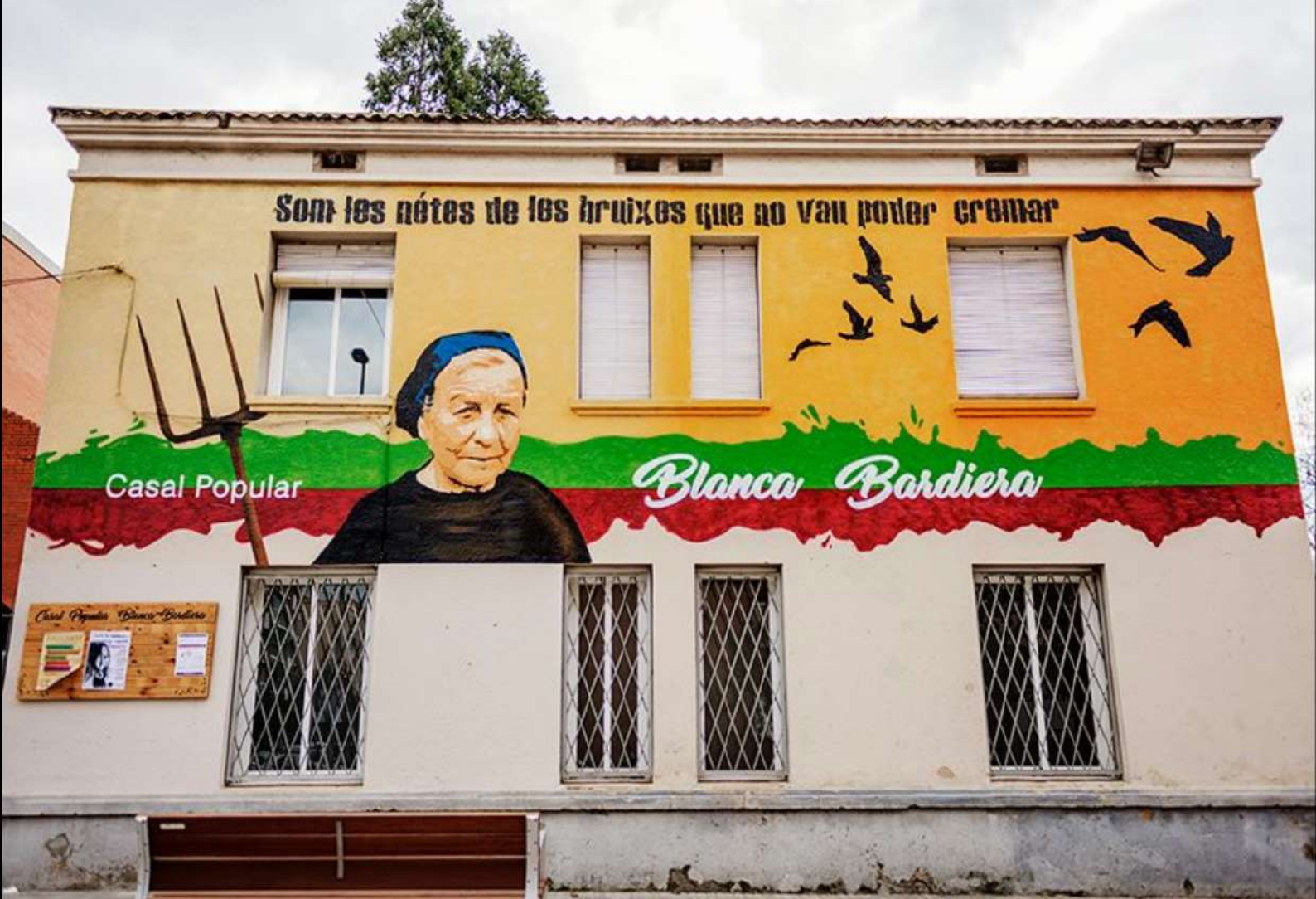
Figura 21. Façana de l'edifici del casal popular Blanc bardeira, a Sant Feliu de Llobregat.
